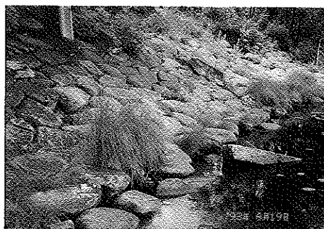
写真-22 ダウガヴァ川の導流水制背後の巨石張護岸。パンス橋下流左岸で、自然石の直径は50~80cm。
