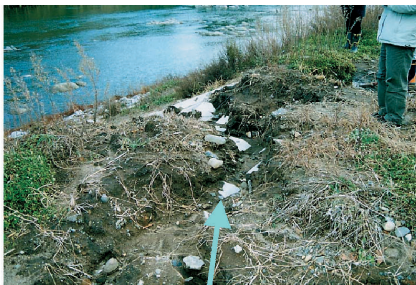
高水敷から法面への水みちには植生が生息していない。
