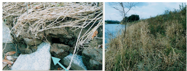
粘性土を用いた覆土
