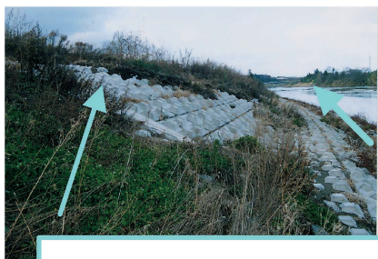
水みち(エロージョン)より下流では、法面全体の覆土が流出していた。
