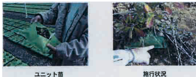
写真-2 ユニット苗工法
