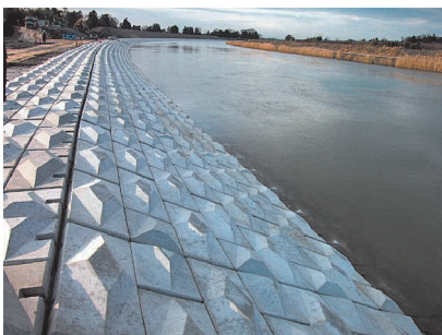
写真-5 水衝部のコンクリートブロック護岸
