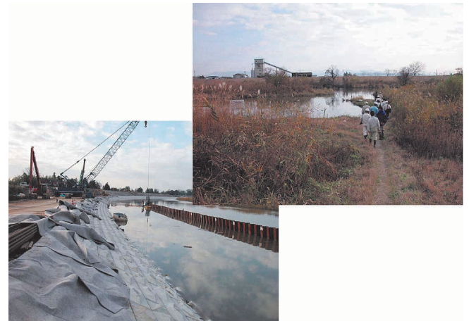
写真-1 小阿賀野川のコンクリート護岸とワンド
