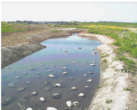
写真-2 せせらぎ式魚道 (菊池川)
