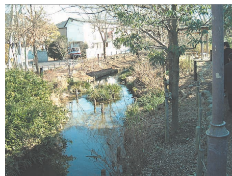
写真-4 土羽水路の整備例
