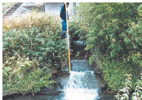
北川との落差 65cm (河口から4kmの用水樋門)
