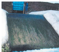
北川との落差 230cm (河口から13.7kmの排水樋門)
