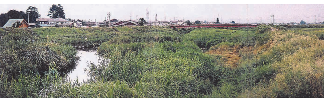
写真-1 本報が適用される河川区間の例
