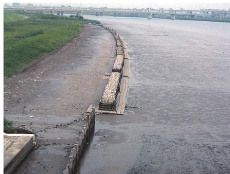
写真-2 小松川地区航走波対策工（木工沈床工タイプ）
