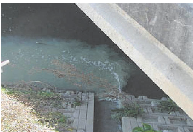
写真-4 生活排水 (白濁水) の流入 (元小山川)
