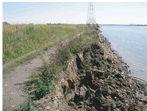
写真-5 河岸崩壊箇所
