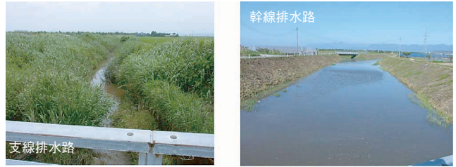
写真-7 新津郷地区の排水路の状況
