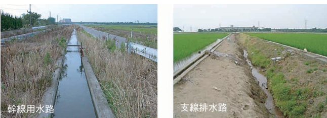
写真-6 亀田郷地区の用・排水路の状況
