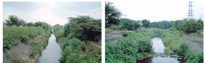
緩傾斜護岸（1.5割）
