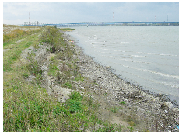
写真-1 河岸浸食の状況
