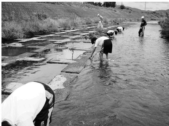
写真-2 現地の状況 (実験箇所b)
