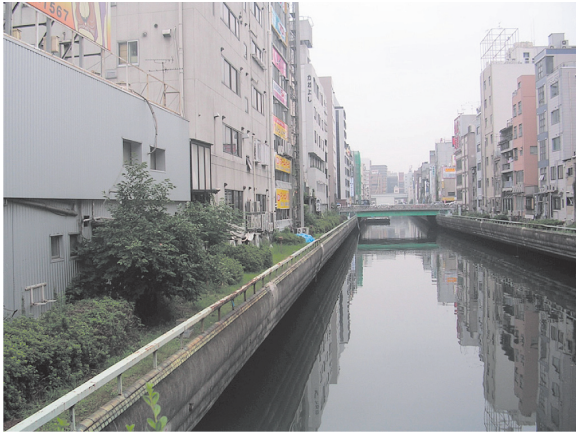
写真-3 道頓堀川の状況（整備前イメージ*3） *3：特例措置の区間に連続する沿川の現在の状況
