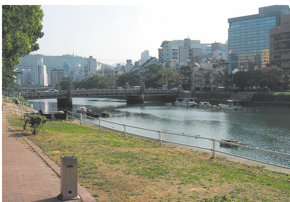
写真-1 京橋川の河岸の状況
