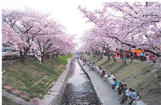
写真一 高田川（大和高田市）
