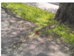
図-8 現況の桜堤構造とクラックの状況
