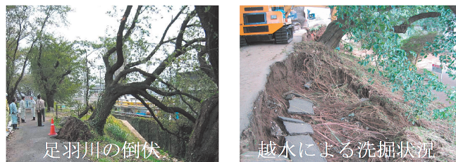
写真-1 足羽川の倒木と越水による堤防の洗掘事例
