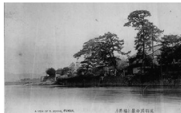
写真-2 明治後期頃の足羽川護岸
