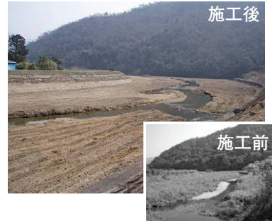
写真-5 砂州切り下げ(施工前・施工直後)
