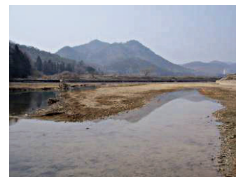
写真－3 たまりの状況（施工直後、平成19年3月）
