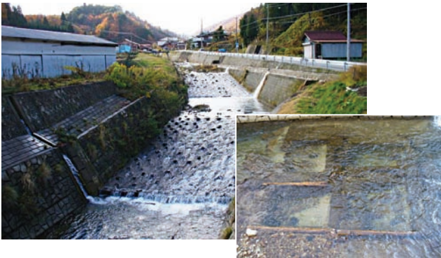
写真-4 平成11年災で施工した斜路
