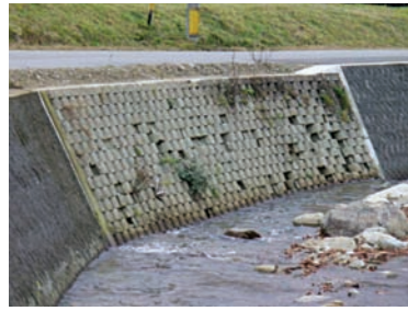
写真-5 被災した空洞ブロック
