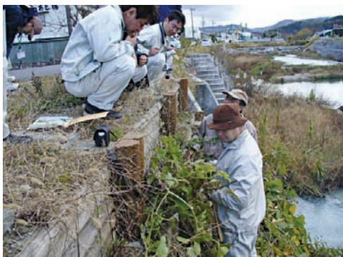
写真-3 現地調査風景
