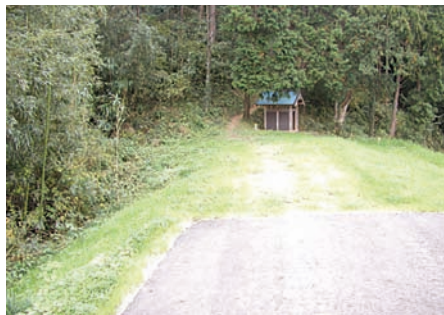
写真-6 堤防道路の分断 (左岸 12.6K 付近) (出典：狩野川水系環境整備計画)
