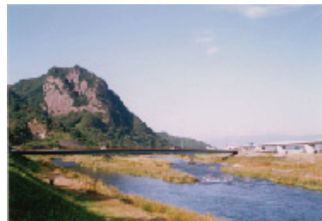
写真-1 連続する瀬・淵、河原等が形成される上流部(城山付近) (出典：狩野川水系環境整備計画)
