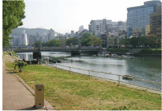
写真-1 京橋川の河岸の状況
