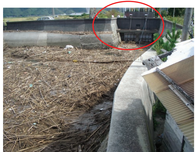
写真-4 流木と漂着ゴミにより樋門の開閉機能が阻害 (熊本県一町田海岸)
