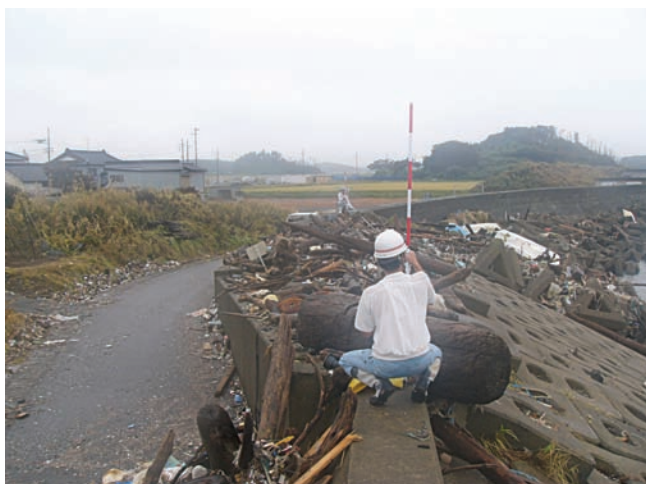
写真-1 流木と漂着ゴミにより消波機能が損なわれた消波工(秋田県平沢漁港海岸)
