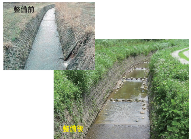
図-4 河床の再自然化の取り組み状況
