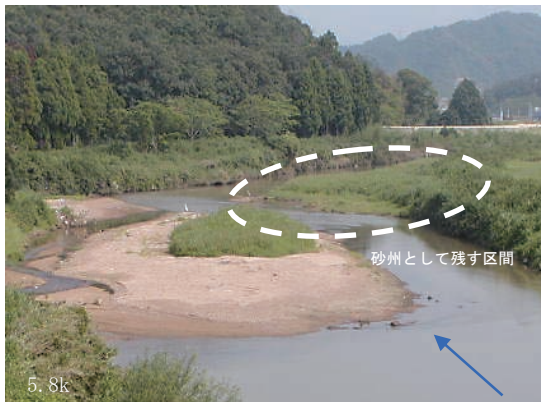
写真-3 湾曲部の水裏部の砂州 (鳥居橋上流) (砂州の堆砂により必要断面が確保されていない)
