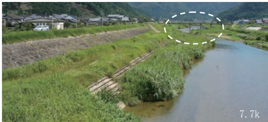
図-10 整備効果の高い堀川橋の状況
