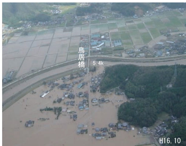
写真-1 台風第23号による出石川の浸水状況
