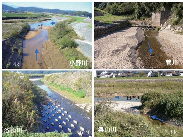
写真-8 出石川に流入する支川の合流部
