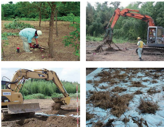
写真-2 伐採（左上）、抜根（右上）、細根除去（左下）、除去した根（右下）
