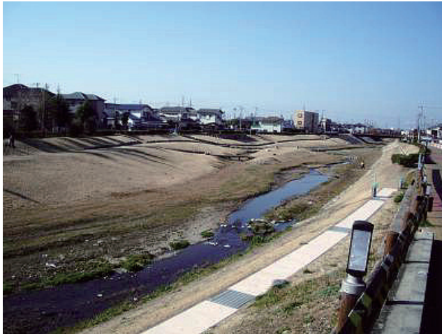
写真-4 まちのシンボルとなった河川空間(喜瀬川)
