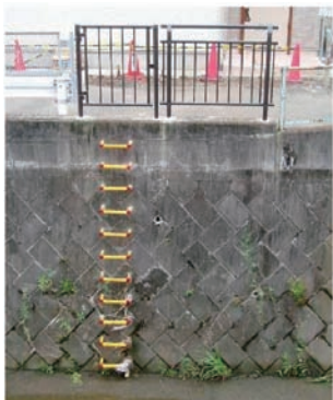
・矢上川梶ヶ谷貨物ターミナル下流に整備されている開閉式フェンス、タラップ(梯子)、取水ビット
