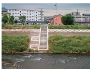
・鶴見川との合流部付近の恩田川に整備されている消火活動にも使用可能な階段(平場に可搬式ポンプを2台設置可能) ・消火活動にも使用できることを示した標識を設置している
