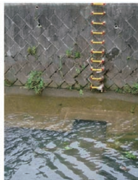
・矢上川梶ヶ谷貨物ターミナル下流に整備されている開閉式フェンス、タラップ(梯子)、取水ビット
