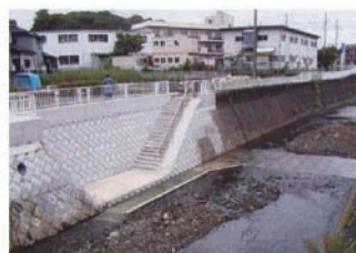
・横浜市旭区の帷子川に整備されている階段と取水ビット
