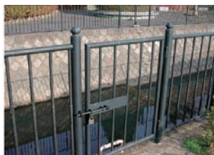
・真光寺川及び真光寺川合流部下流の三輪地先に整備されている開閉式フェンス
