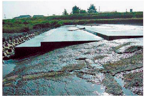
写真-5 魚類等の遡上・降下の阻害となっている横断工物(高木井堰)
