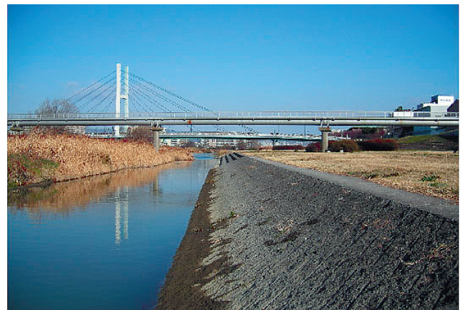
写真-1 低水護岸整備に伴う水陸移行帯の消失
