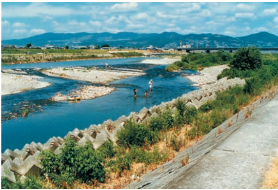
写真-2 箕面川合流付近の猪名川 (S60年)
