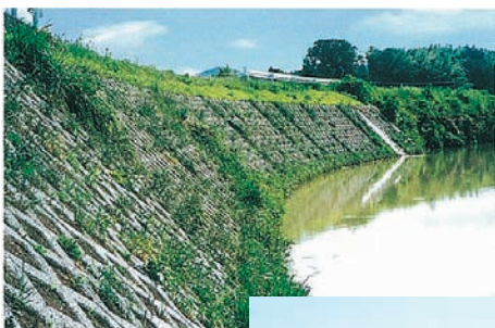
↑河岸に工夫が見られるが、河床幅が狭く、川の動きを制約している 写真-1 課題の残る事例
