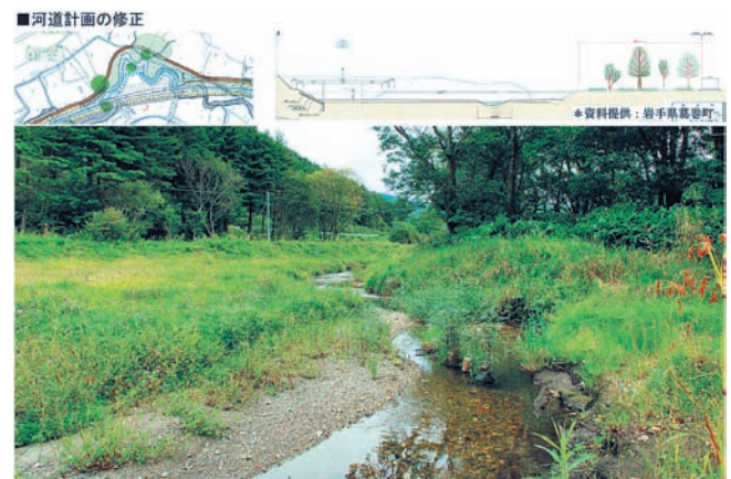
写真-6 旧川蛇行部を埋めずに新河道と一体的に整備した区間(土谷川)
