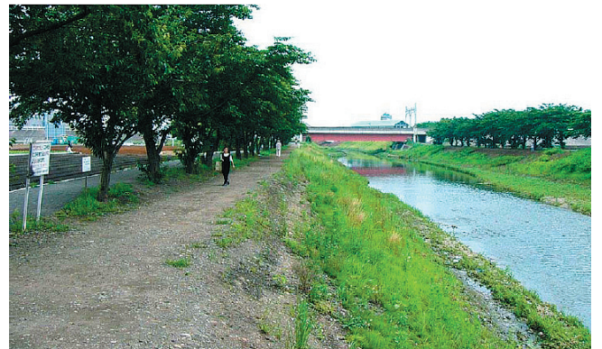
写真-5 掘り込み河道とし桜並木を保全 (黒目川)
