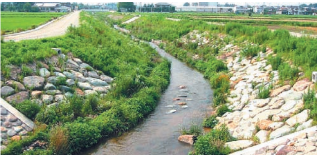
↑河岸に工夫が見られるが、河床幅が狭く、川の動きを制約している 写真-1 課題の残る事例
