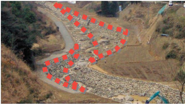
写真-4 拡幅による河積の確保 (山附川)
