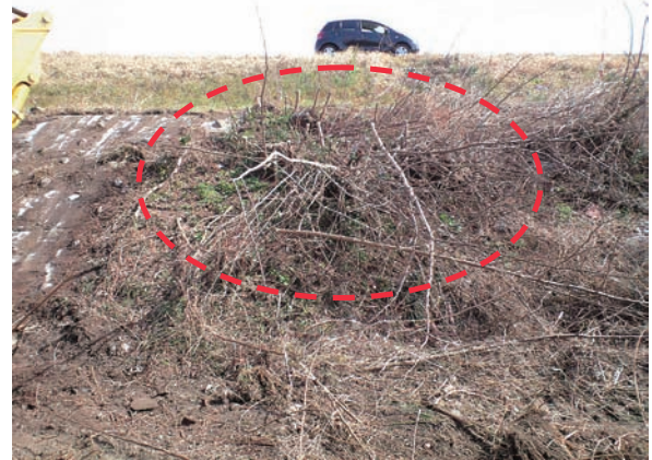
写真-2(1) 堤防法面（護岸）から繁茂するハリエンジュ
