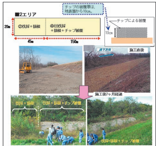
写真-8 (3) 試験施工の概要 (7.5k 右岸)
