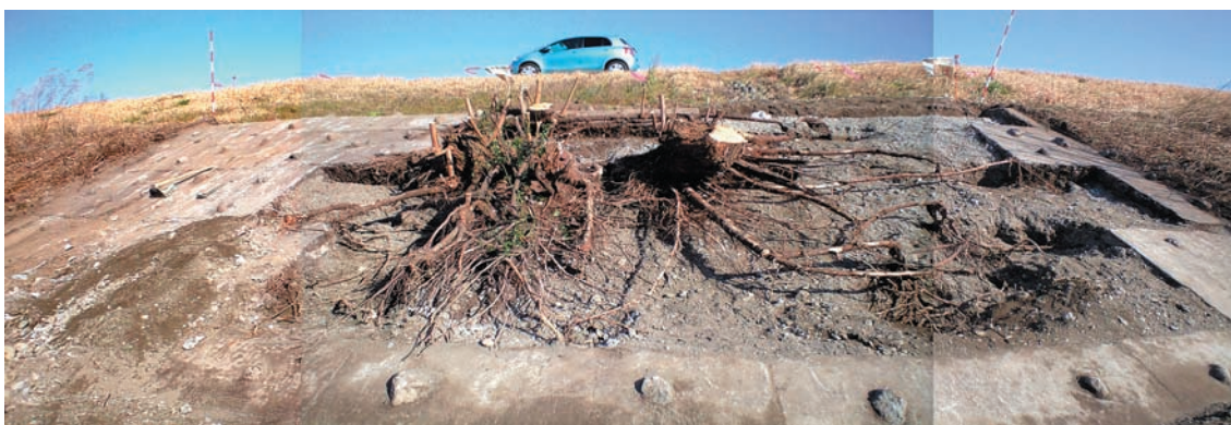
写真-2(2) ハリエンジュ地下茎の護岸侵入状況（神流川7.6k 右岸）
