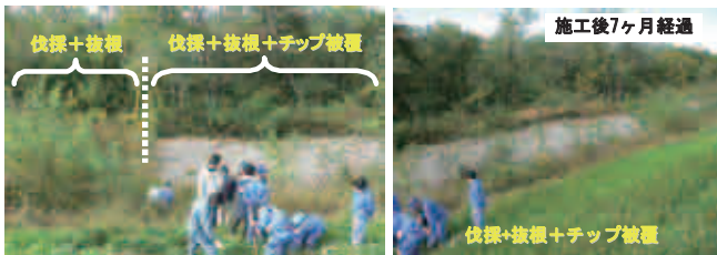
写真-6 「伐採+抜根+チップ被覆」
