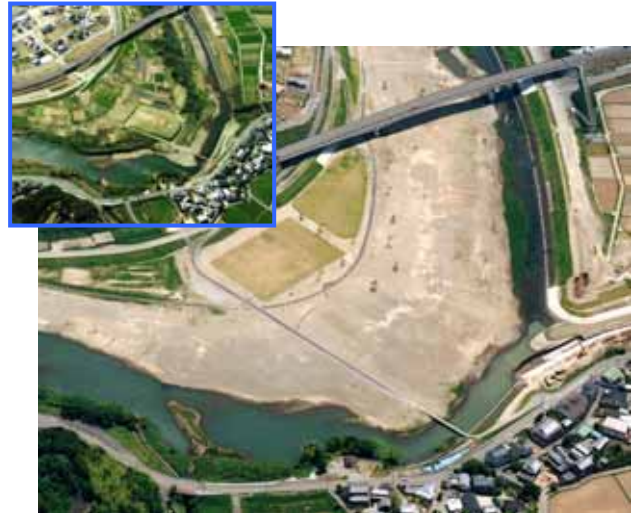
図 - 2 五ヶ瀬川野田地区河道掘削工事の状況 (左:工事前 H19.3、右:工事後 H22.5)
