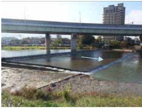
写真 - 4 MM整備区間直上流の取水堰
