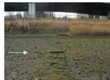
写真 - 5 確認された既設の帯工
