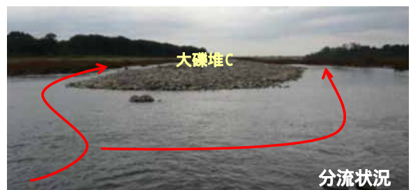
写真 - 3 大礫堆の設置により復元した複列流路
