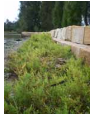
図 - 11 矢板撤去後の護岸
