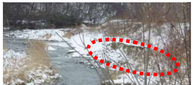
図 - 6 隠し護岸の被災の状況
