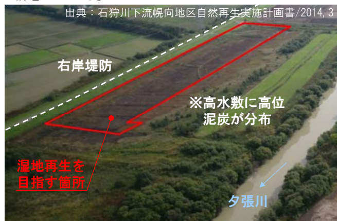
写真-1 湿地再生を行おうとする箇所の様子 2)
