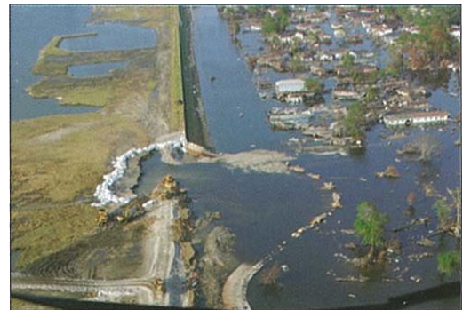
図-5 ハリケーン・カトリーナにより決壊した堤防 (出典: アメリカ・ニューオリンズ市)
