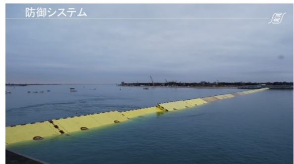
図-9 「モーゼ計画」の主軸となる可動堰(出典:イタリア・ベネチア事業連合)
