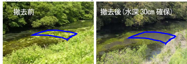
図-4 最下流部の堆積土砂撤去箇所 (H25 施工)
