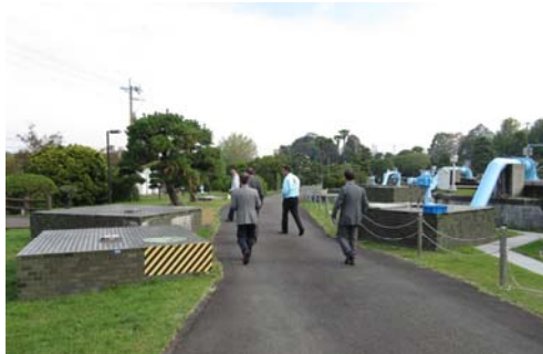
写真-2 健軍水源地の取水井戸
