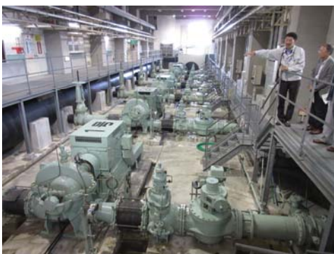
写真-4 上水道配水ポンプ施設
