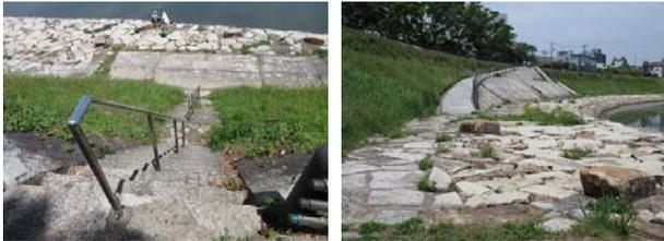
写真-6 水辺へのアクセス状況 (左: 急勾配の階段、右: スロープから続く歩行性の低い回遊路)
