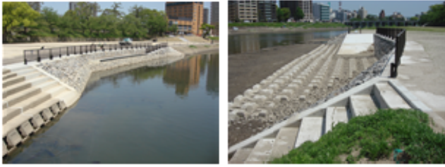
写真-4 船着場・船上げ場の竣工状況
