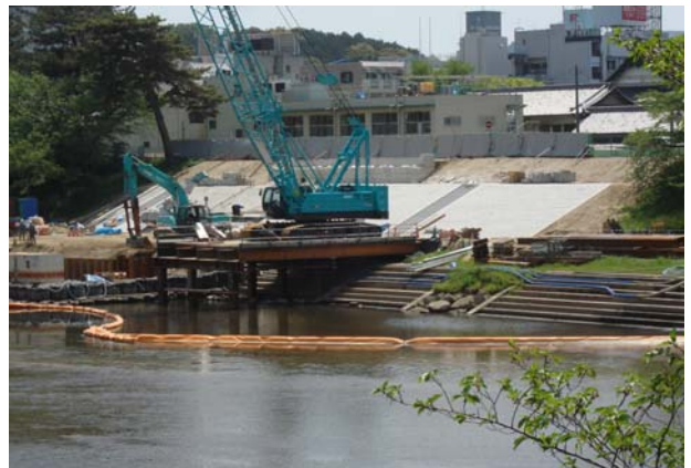
写真-3 人道橋の左岸取付部の工事状況
