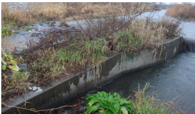
写真-1 土砂により閉塞した魚道の例 (セグメント1の区間にある魚道)
