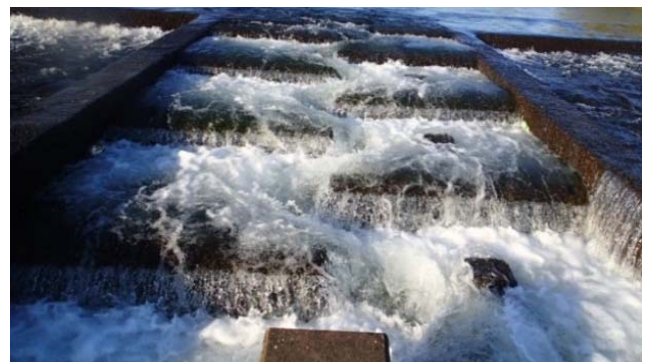
写真-3 流量過多で流れが乱れた魚道の例
