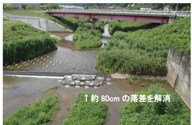
写真-3 八代水門の落差改善状況(国)
