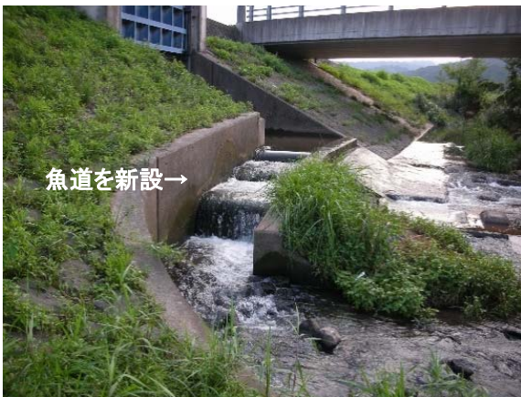
写真-5 長田樋門の落差整備後（県）
