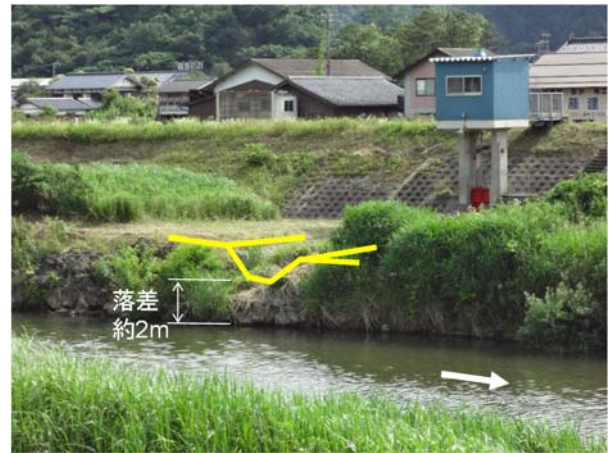
写真-8 寺内第一樋門の落差整備前
