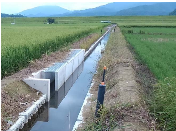
写真-1 生態配慮型水路に設置した水田魚道
