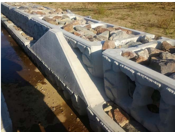
写真-2 生態に配慮した坂路(カエル道)
