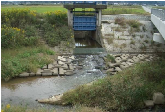
写真-4 長田樋門の落差整備前（県）
