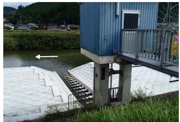
写真-9 寺内第一樋門の落差整備後
