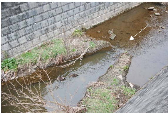
写真－2 バープ工の設置例
