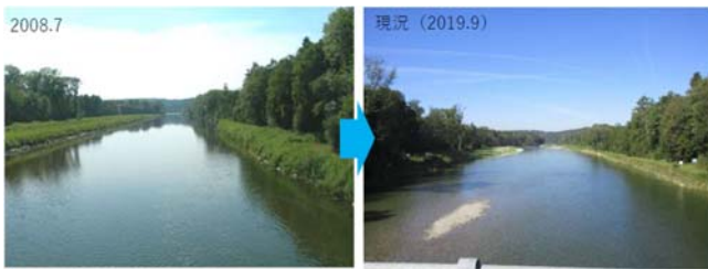
写真-2 護岸撤去による砂州の形成（左岸） （左：ベンツィガー氏資料 右：池内氏撮影）
