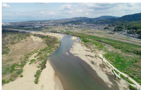
図-1 中聖牛 9 基が設置された木津川砂州
