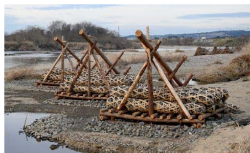
図-2 2019年11月に設置した中聖牛
