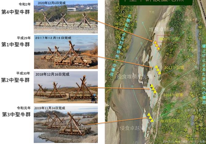
図-1 中聖牛 12 基が設置された木津川玉水橋下流砂州
