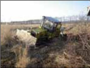
施工箇所での重機沈下状況(秋)
