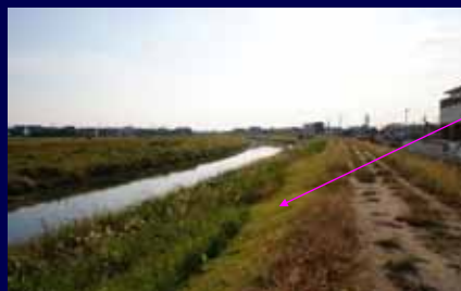
流速から判断して護岸を設置していない事例(長田川:愛知県)
