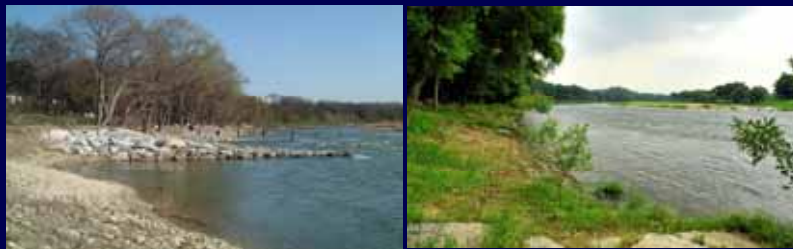
低水河岸に水制工を設置した事例(矢作川:愛知県)
